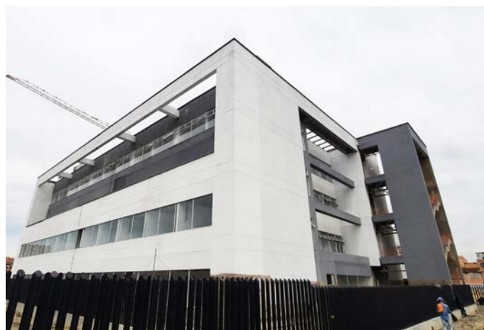
Figura 10 - Avances de obra.
